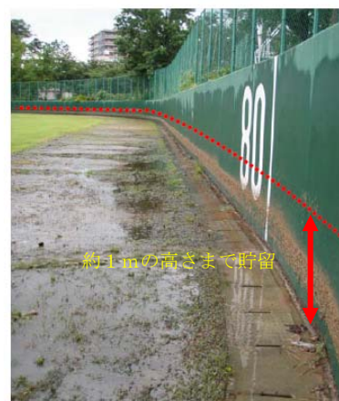
【山王1号雨水調整池】
