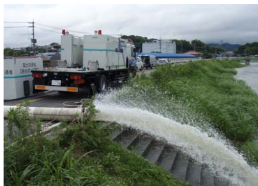
【排水ポンプ車 派遣状況（九州北部豪雨災害）】
