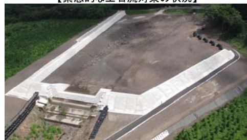
【緊急的な土石流対策の状況】
