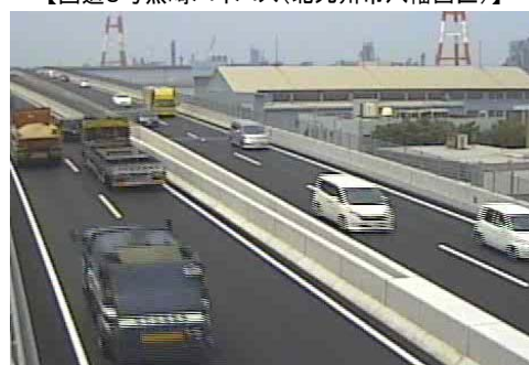
【国道3号黒崎バイパス(北九州市八幡西区)】
