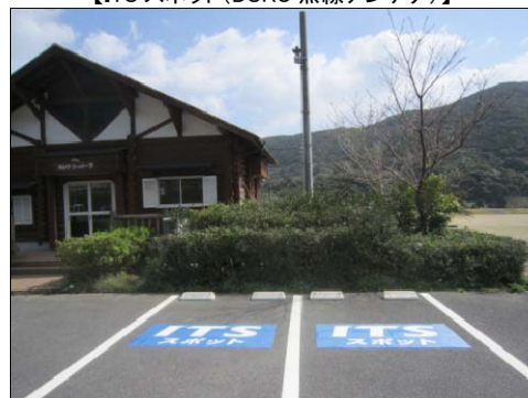
【ITS スポット(DSRC 無線アンテナ)】
