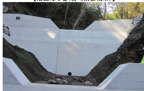
【治山えん堤（宮崎県都城市）】
