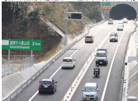
【西九州自動車道（唐津IC～唐津千々賀山田IC間）】
