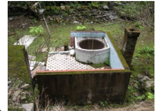
風呂釜のみが残された家屋跡
