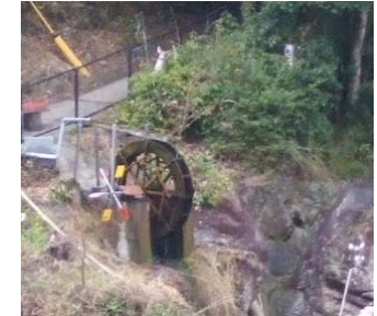
ちごの滝の横に 設置された水車
