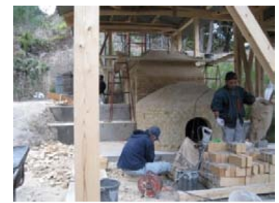
建設中の登り窯
