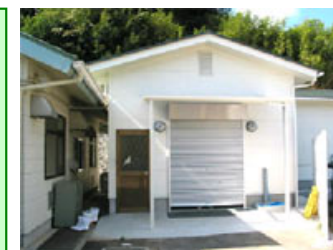
解体処理施設 * 3
