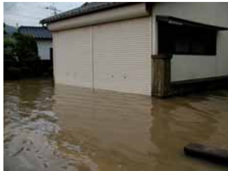
六角川の浸水状況(佐賀県武雄市)
