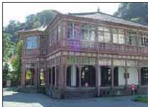
旧鹿児島紡績所技師館
