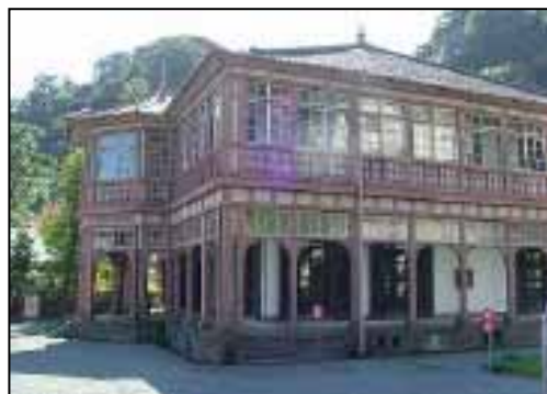
旧鹿児島紡績所技師館
