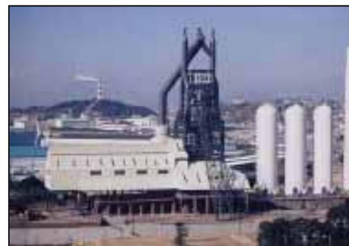
東田第一高炉跡
