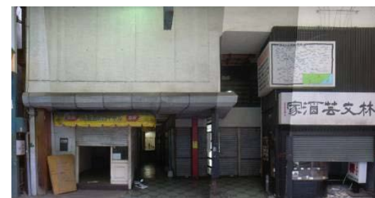
空き店舗(改装前)
