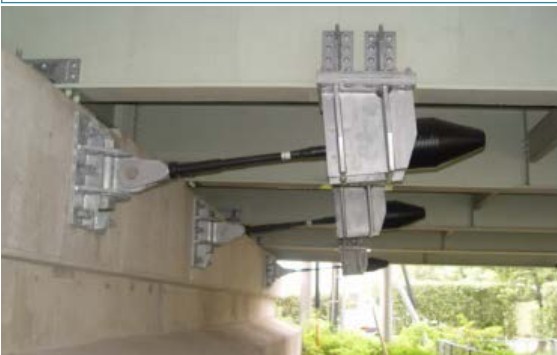
落橋防止装置の設置
