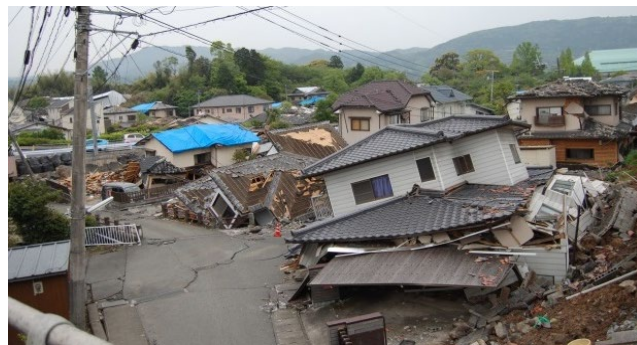
熊本県益城町の被害(平成28年熊本地震)
