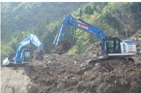
土砂撤去作業
