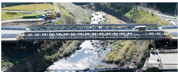
応急組立橋による交通路の確保
