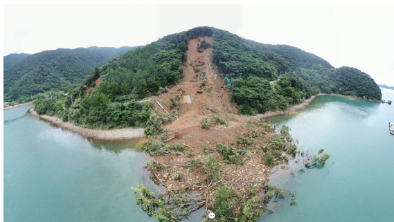
ドローン等のICT技術による調査
