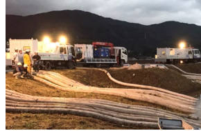
排水ポンプ車による緊急排水
