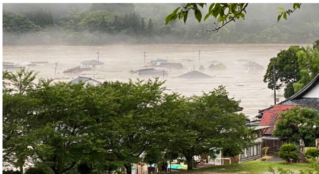
熊本県球磨村の被害(令和2年7月豪雨)
