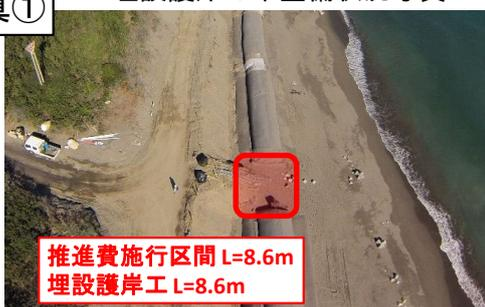
埋設護岸の整備状況写真(サンドバック充填後)
