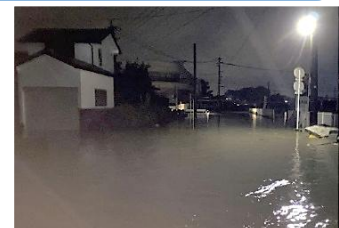
令和2年7月出水による浸水状況
