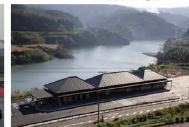
ダム湖畔に「道の駅のつはる」オープン
