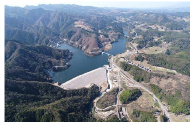
試験湛水中の大分川ダム
