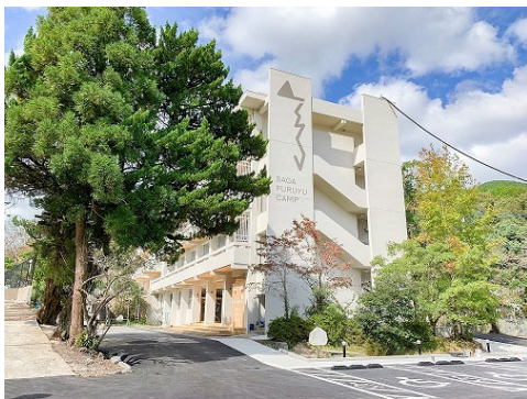
廃校した佐賀市立富士小学校が生まれ変わった
