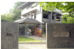
うしのくら・ショールーム棟
