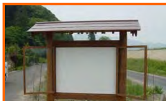
15. 5. 22の看板設置状況
