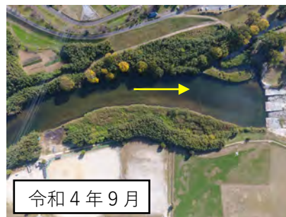
河道内樹木 着手前
