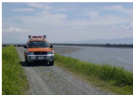
河川巡視の状況
