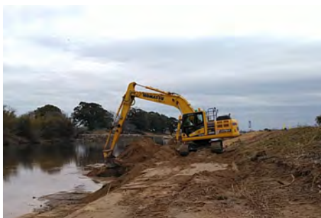
河道内土砂掘削状況
