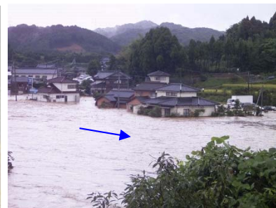
水留橋付近の状況 (徳須恵川 12/600付近：伊万里市南波多町)
