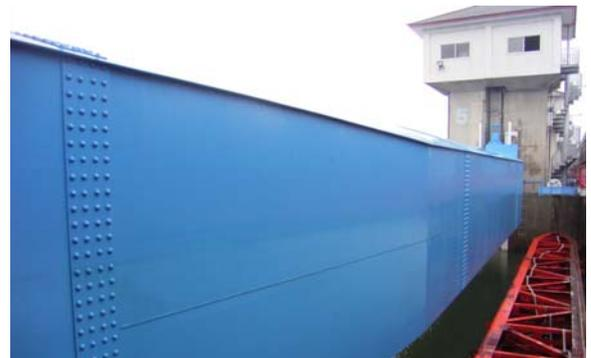
写真 4.3.7 ゲート塗装前・後（防錆対策）
