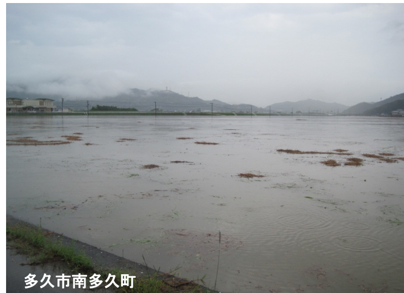
牟田辺遊水地（多久市南多久町）の貯留状況（7/13 15:35）
