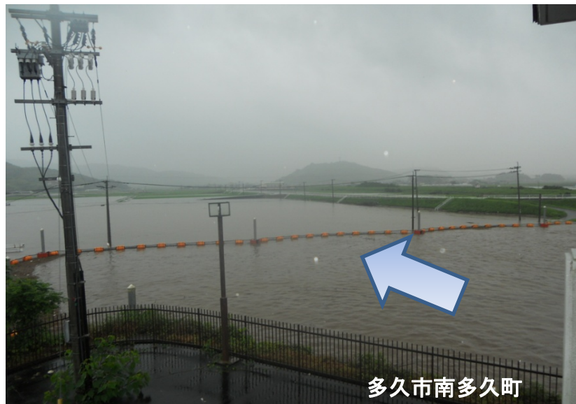
牟田辺遊水地（多久市南多久町）の貯留状況（7/13 15:30頃）
