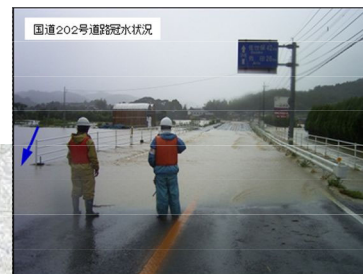
○出水時被害状況(H18.9出水)
