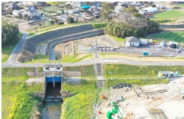
池上排水機場 施設全景
