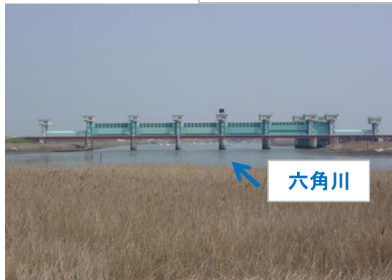
六角河口堰 施設全景
