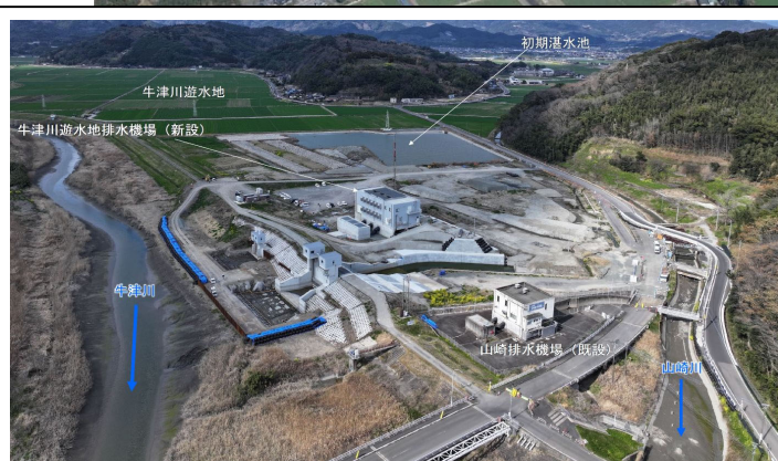
【牛津川遊水地排水機場：施工状況写真R8.3中旬】
