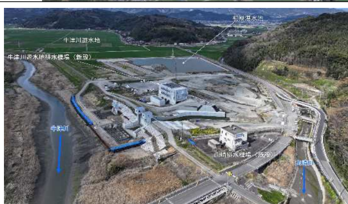
【牛津川遊水地排水機場：施工状況写真R8.3中旬】
