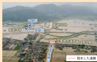
平成2年7月出水の浸水状況
