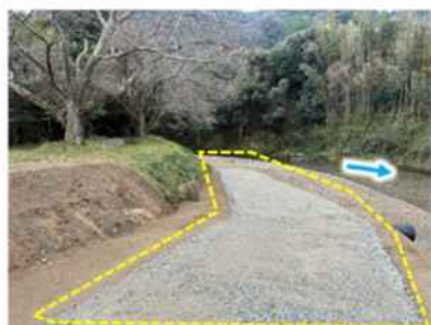
仮設スロープの整備（勾配7%）
