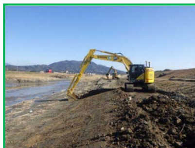
河道掘削状況
