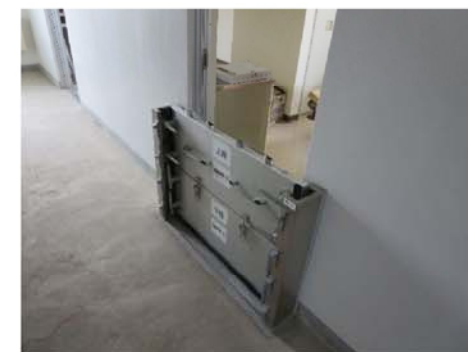
管理室入口防水壁設置時
