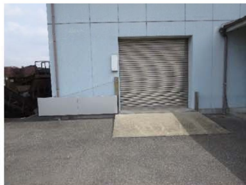
通常防水扉開放時
