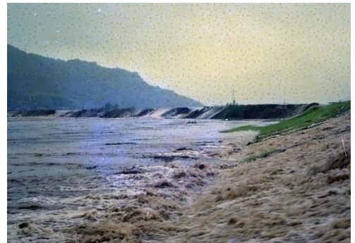
平成 2 年 7 月洪水（多久市）
