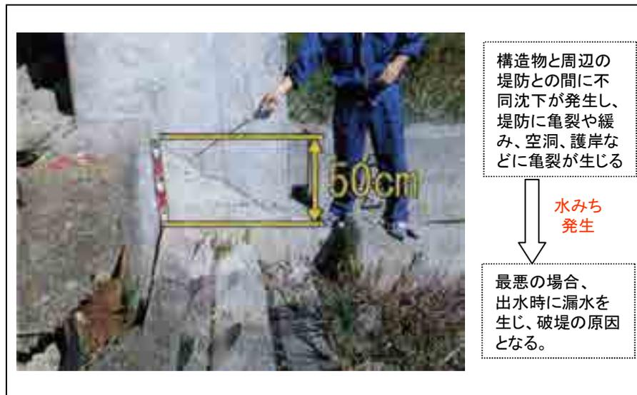
図 2.1.5 排水樋管周辺の地盤沈下
