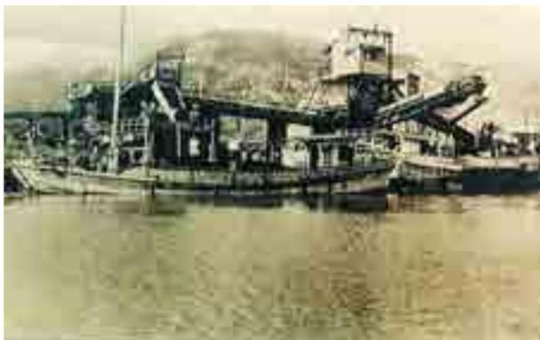
写真 1.1.13 ベルトコンベアによる石炭の船積
