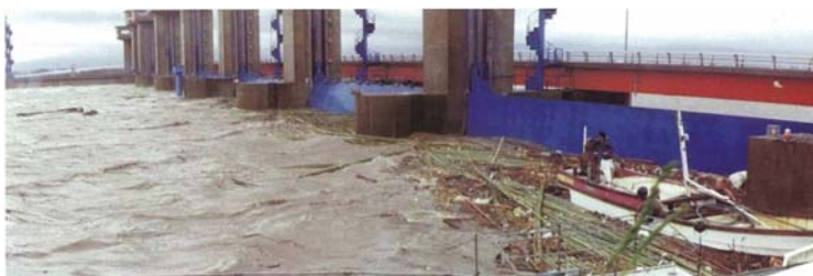
写真 昭和 60 年台風 13 号での高潮防御状況
