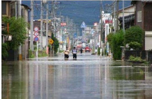
写真 H21 年 7 月出水 (武雄市高橋地区内水被害)
