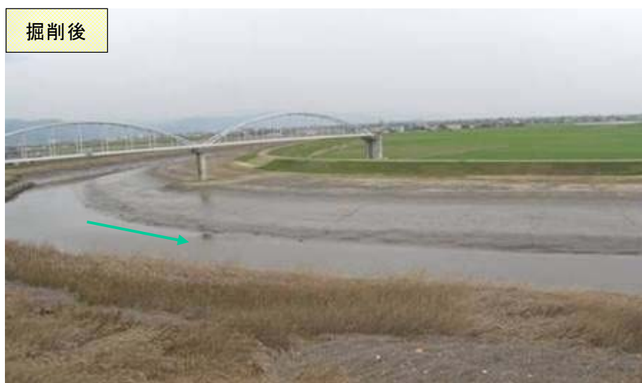
牛津川下流部の河道掘削
