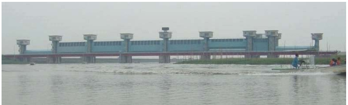
写真 六角川河口堰（昭和 58 年完成）
