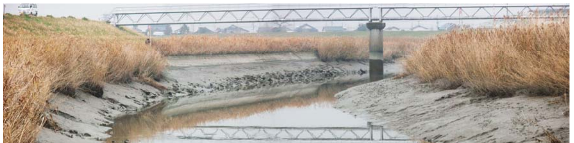
写真 河道に堆積するガタ土
