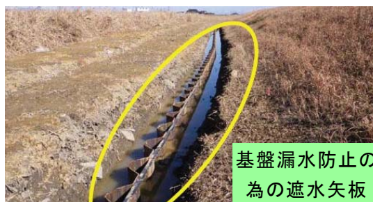
写真 堤防基盤漏水への対策事例
