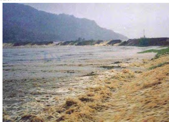
④ 小城市牛津町での堤防からの越水状況（納所地区） のうそ
