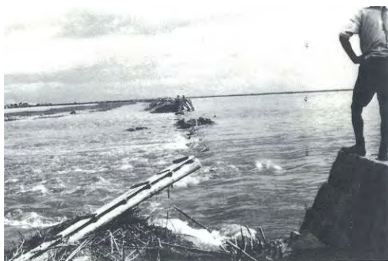
ふくどみまちしょうわがらみ 写真 1.2.11 旧福富町昭和棚ではん濫状況 (昭和 34 年 9 月台風 14 号)
