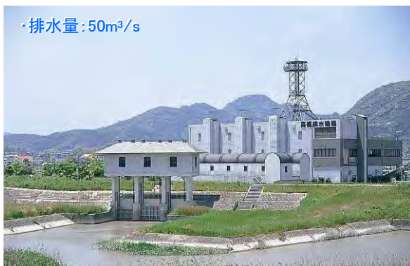
写真 1.2.18 高橋排水ポンプ場 (平成9年3月完成)
