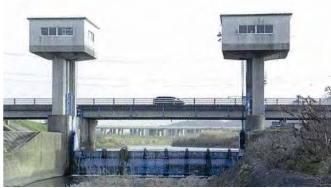
写真 1.2.15 大日堰 (昭和 57 年 3 月完成)
