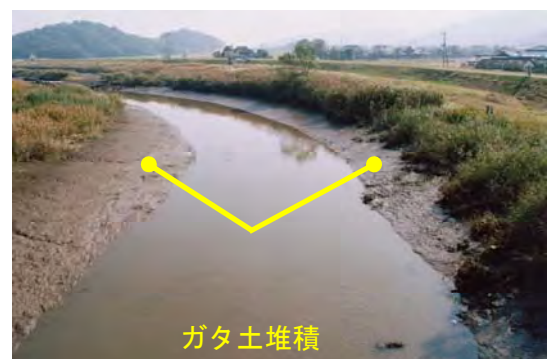
写真 1.1.1 ガタ土堆積状況
