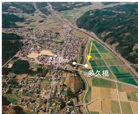
写真 1.1.6 牛津川上流部 (多久橋付近)
