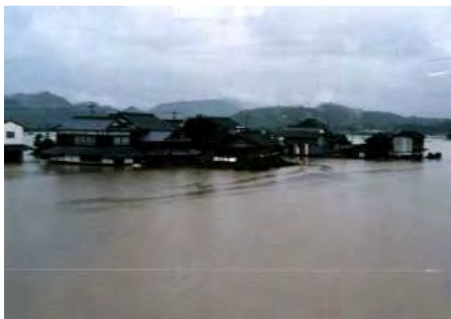
写真 1.2.8 武雄市橋町での浸水状況（平成7年7月）
