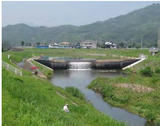
写真 1.2.16 小井手堰 (平成 17 年 3 月完成)
