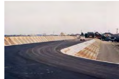
写真 1.2.20 高潮堤防の整備
