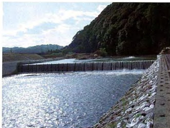
写真 1.2.17 大井手堰 (平成 17 年 1 月完成)
