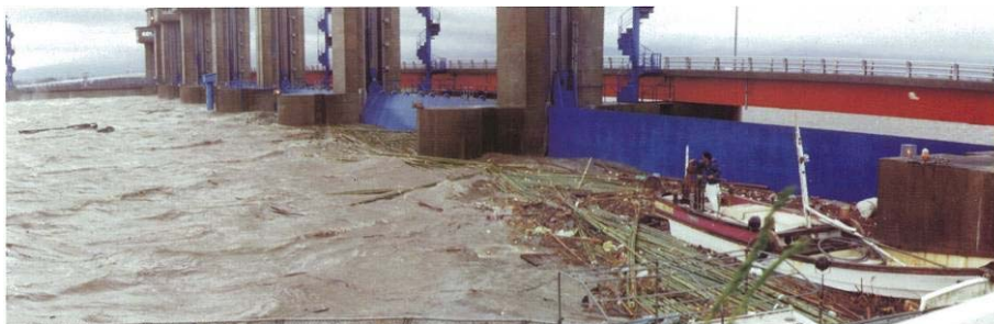
写真 2.1.7 昭和 60 年台風 13 号での高潮防御状況
