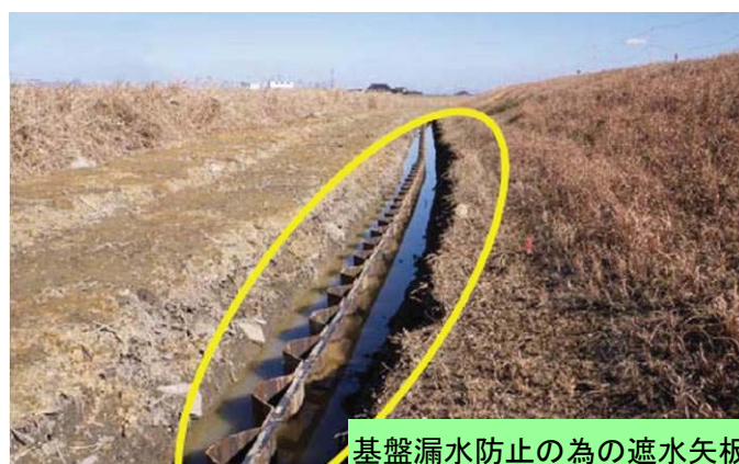
写真 2.1.3 堤防基盤漏水への対策事例
