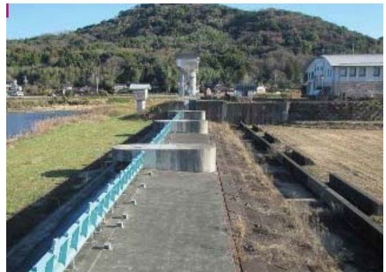
写真 2.1.17 牟田辺遊水地越流堤
