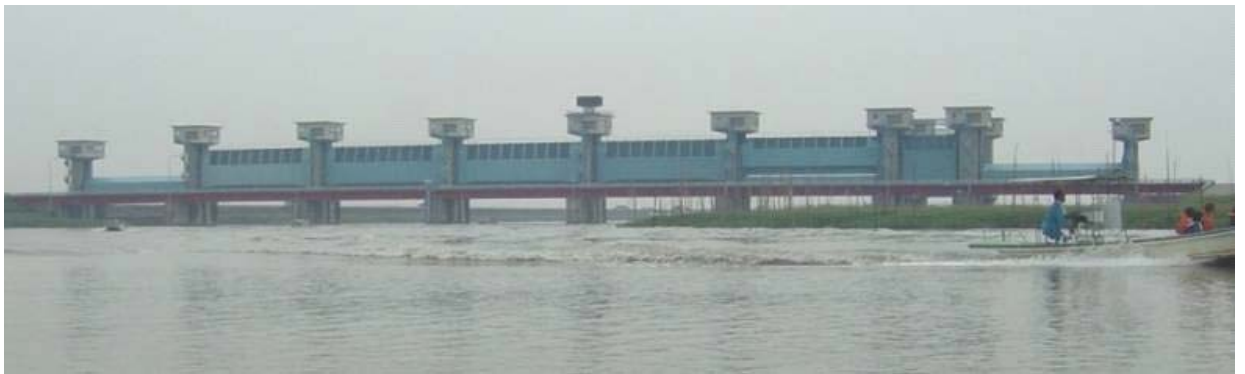
写真 2.1.6 六角川河口堰（昭和 58 年完成）
