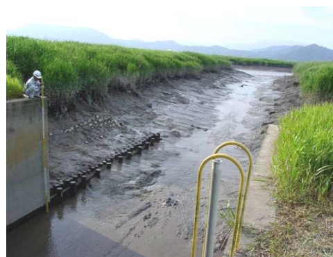
写真 2.1.15 ガタ土除去後の状況
