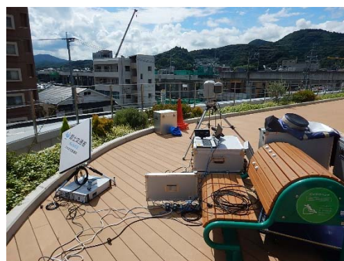
写真 2.1.19 衛星通信可搬局装置
