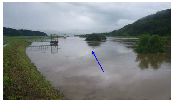
写真 2.1.10 河道内樹木による流下阻害状況
