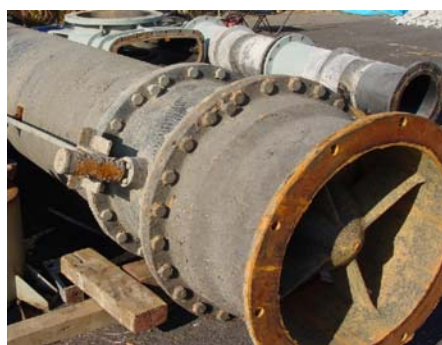
排水機場等の大規模補修 (30～40 年に一度)
