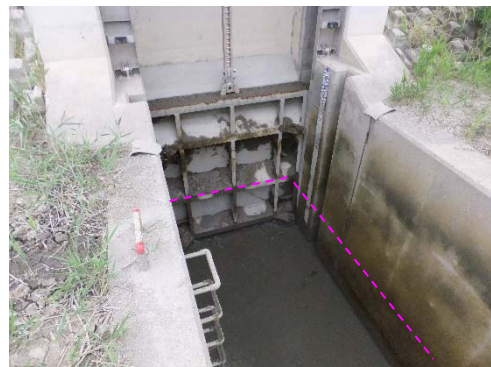
写真 2.1.13 ガタ土除去後の状況
