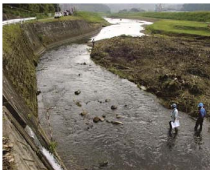
写真 2.3.31 覆土前のコンクリート低水護岸
