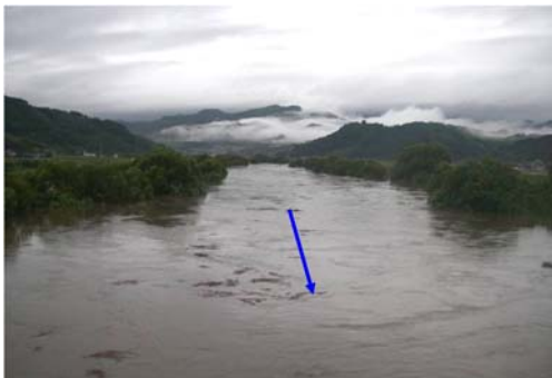
写真 2.1.9 牛津川中流部の河道内樹木繁茂状況
