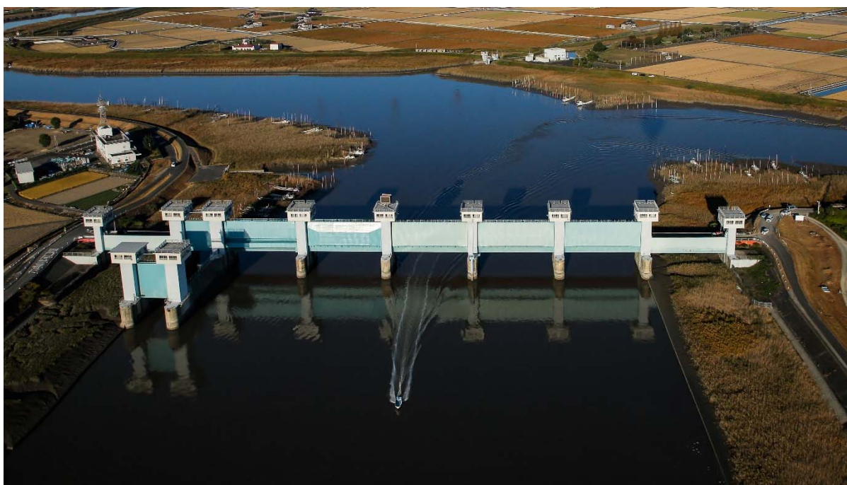
写真 5.2.8 六角川河口堰の状況
