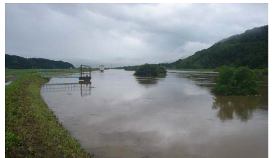
写真 5.2.6 河道内樹木による流下阻害
