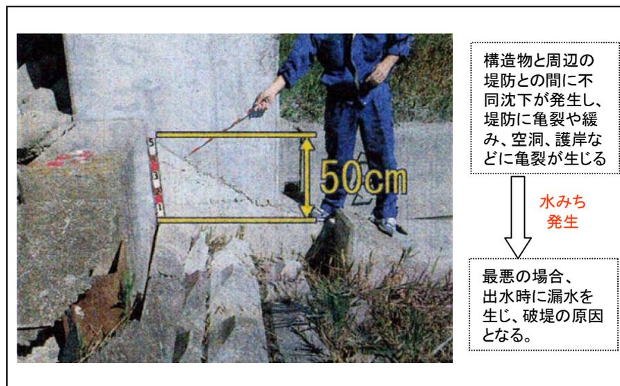
図 2.1.8 排水樋管周辺の地盤沈下
