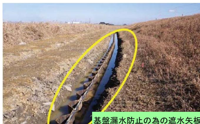
写真2.1.3 堤防基盤漏水への対策事例
