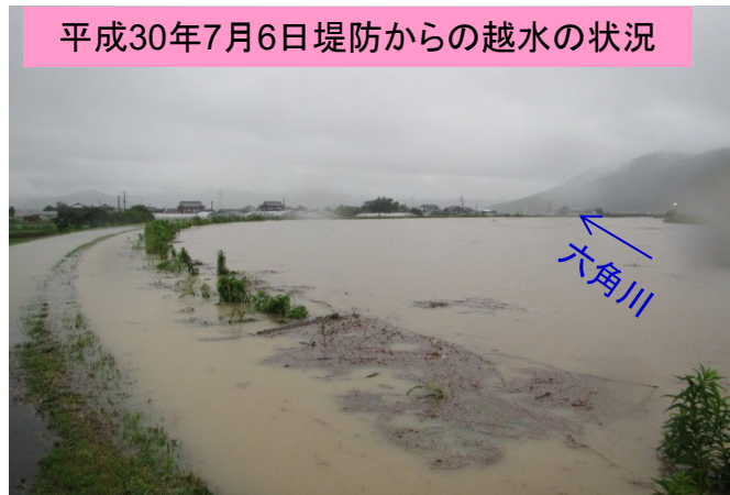
▲ 武雄市橘町(六角川左岸28k800付近)
