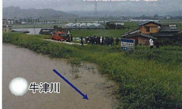
小城市牛津町砥川地区 国道34号牛津大橋上流付近
