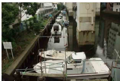
狭隘な河川内に不法係留があり、流下阻害のおそれがある。 呑川水系呑川
