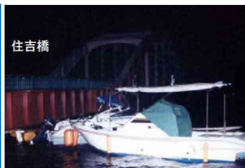
流出した不法係留船が橋梁に衝突した。 流下阻害の危険。 太田川水系旧太田川
