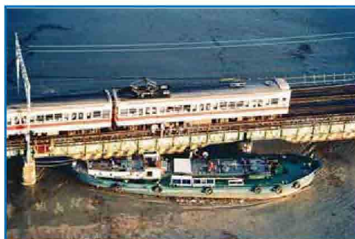
船舶が鉄道橋に衝突し、列車の運行が止まった事例。 荒川水系荒川
