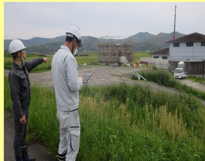
遠隔操作システムの導入(大町町)
