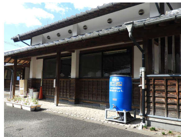
【雨水貯留タンクの設置】
