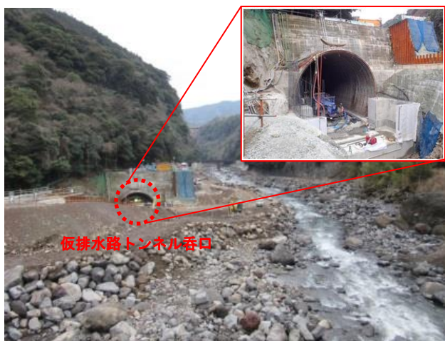
写真-3 仮排水路トンネルの状況（地震前）
