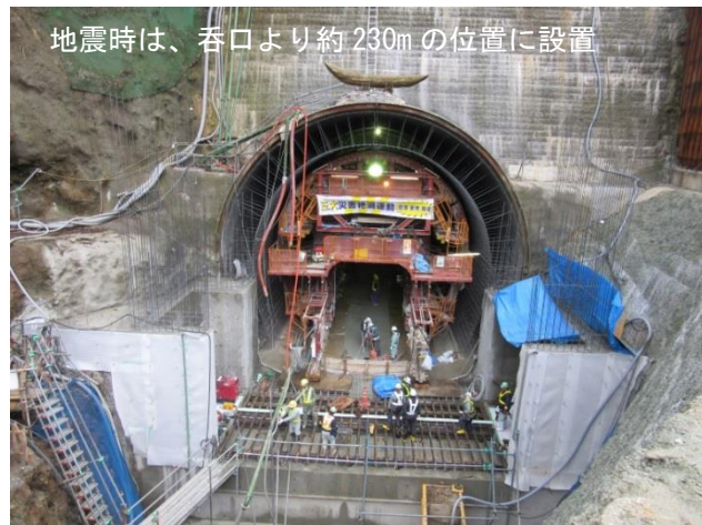
写真-2 型枠の設置状況（地震前）
