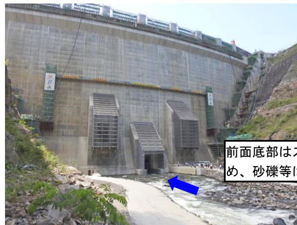
写真－４ 立野ダムのスクリーン
