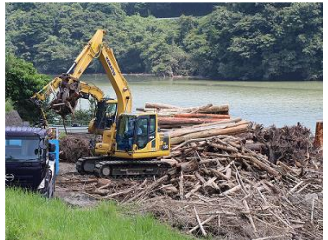
写真－4 流木の回収状況
