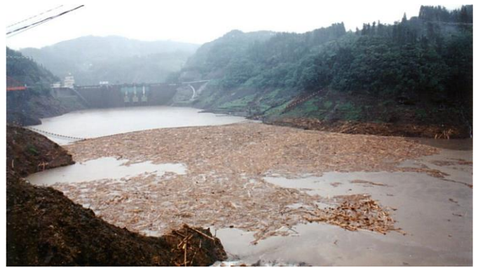
写真－2 貯水池内の流木状況
