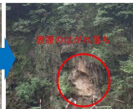
ダム敷右岸（地震後）
