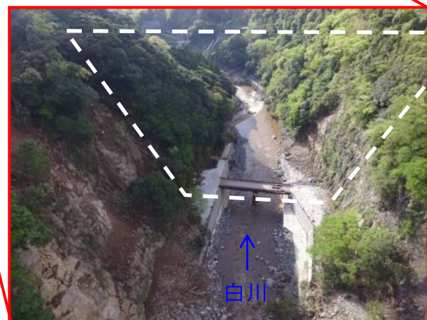
ダム建設予定地付近の状況 (H28.5)
