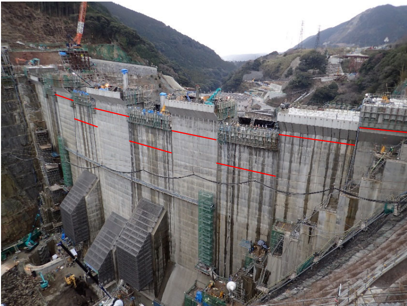
令和5年1月末時点(赤線より上部を打設)
