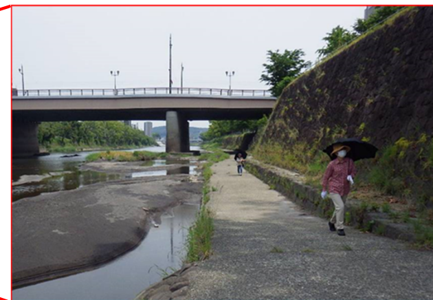
下流河川の遊歩道の状況
