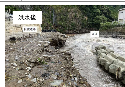
仮排水トンネル工事用道路被災状況
