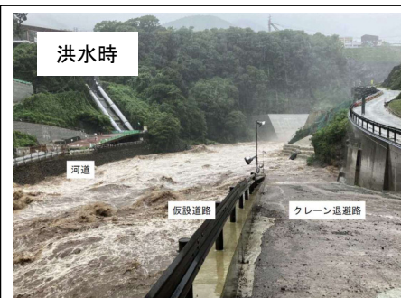
仮排水トンネル工事用道路被災状況
