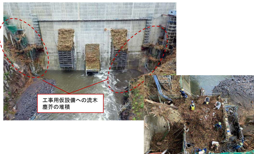
令和5年7月14日撮影 工事用仮設備堆積状況
