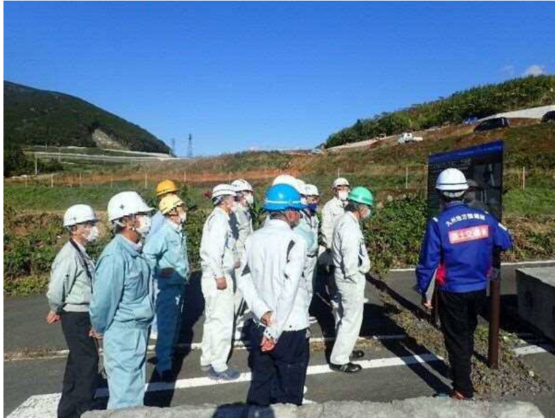
R2.11 土木施工管理技士会現地説明【14名】
