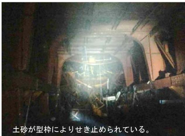
写真-1 仮排水路トンネルの土砂堆積状況
