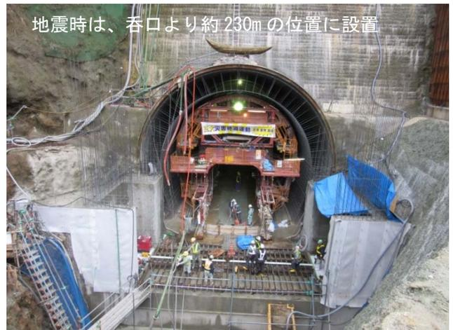
写真-2 型枠の設置状況（地震前）
