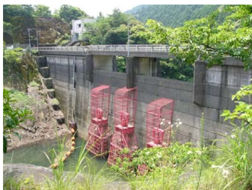
原野谷川農地防災ダム（静岡県）
