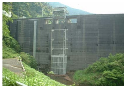
大代川農地防災ダム（静岡県）
