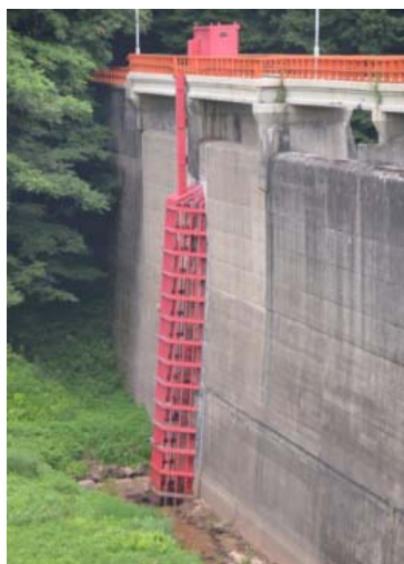
外柵沢ダム（岩手県）
