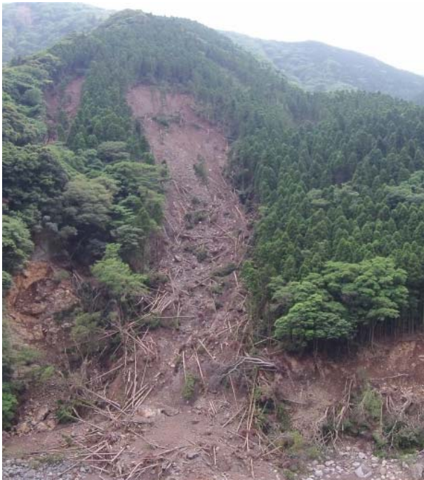
写真－1 立野ダムサイト上流倒木
