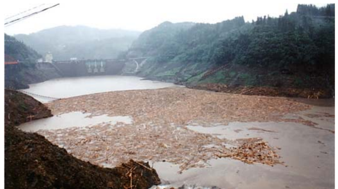
写真－2 貯水池内の流木状況
