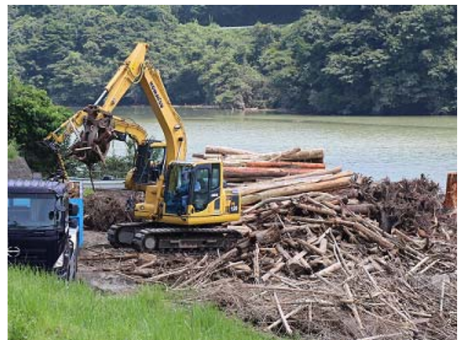
写真－4 流木の回収状況
