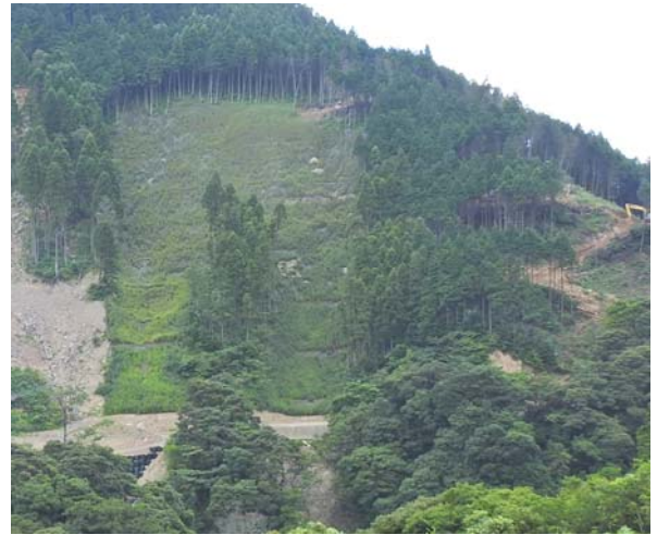
写真－2 斜面对策完了後の状況
