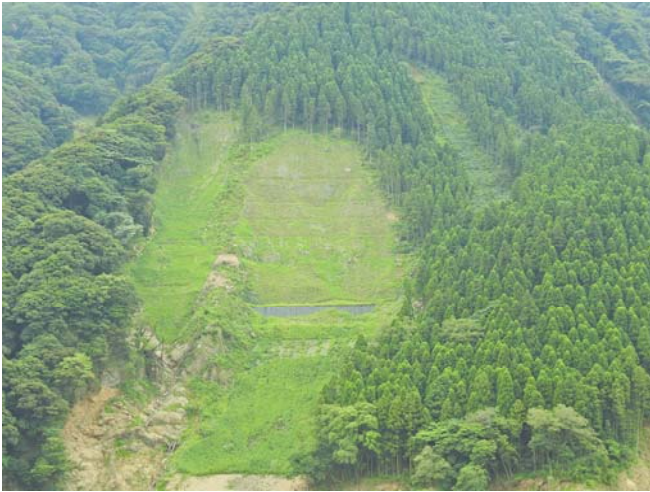
写真－1 斜面对策完了後の状況
