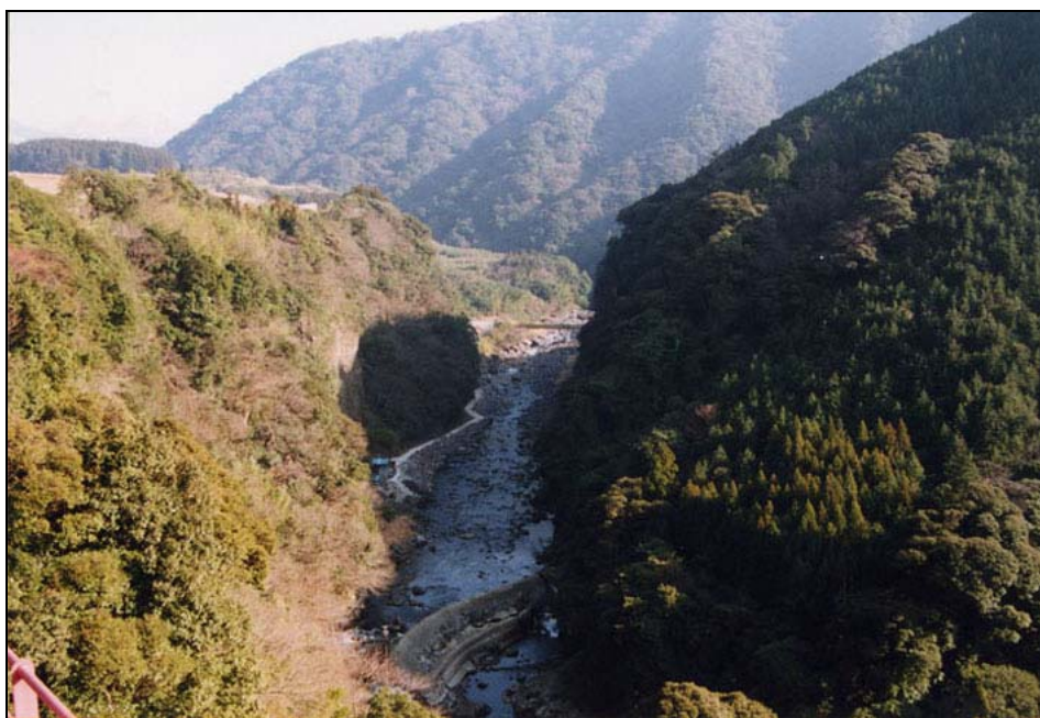
写真 5.9-1(4) 立野橋梁からの現況の眺望景観の状況（冬季）
