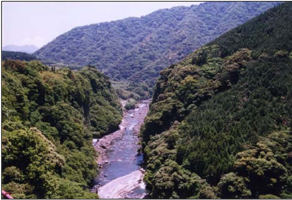
写真 5.9-1(1) 立野橋梁からの現況の眺望景観の状況（春季）
