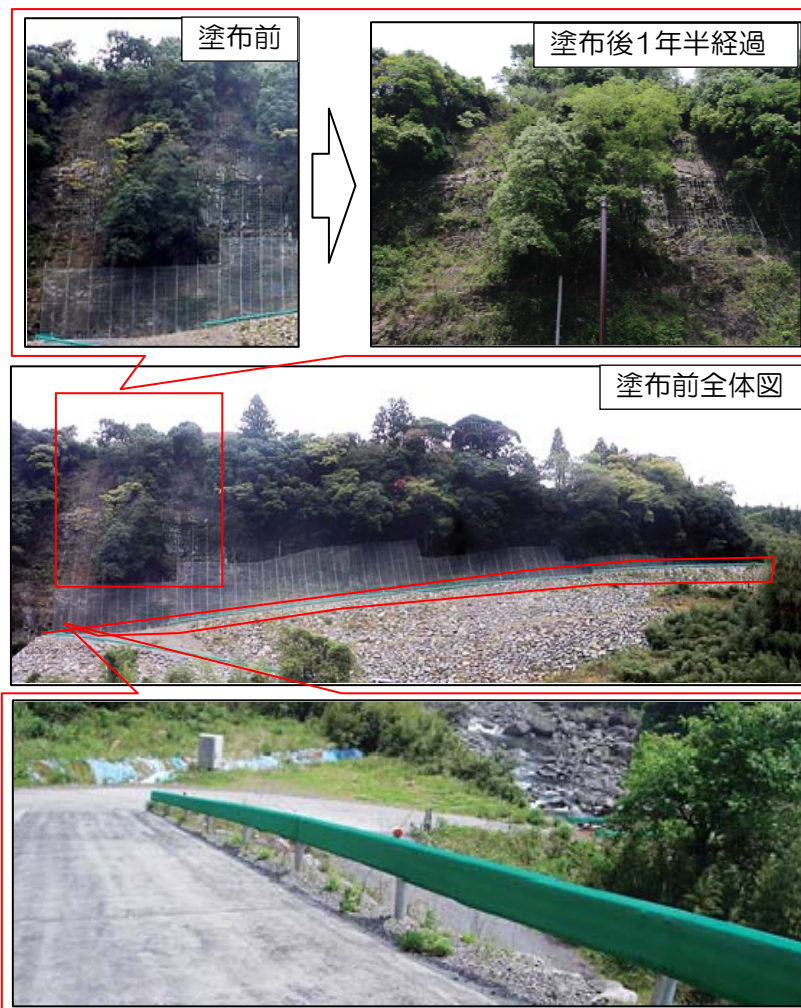
写真 6.2-2(1) 視覚に対する配慮（落下防止用金網・ガードレール）
