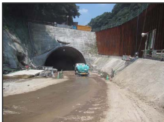
散水の状況(転流工トンネル)
