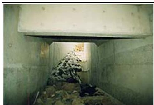
ボックスカルバート内の状況
