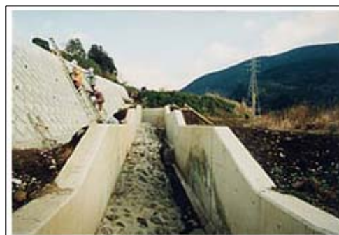
ボックスカルバート出口の水路
