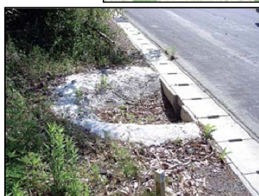
写真 6.2-2(4) U字側溝の脱出口設置状況
