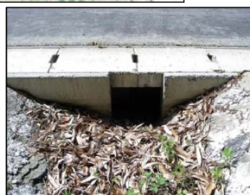
写真 6.2-2(4) U字側溝の脱出口設置状況
