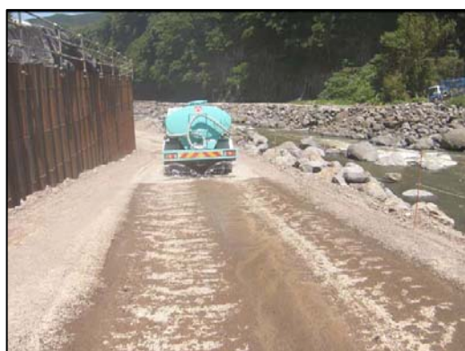
散水の状況(河川沿い)
