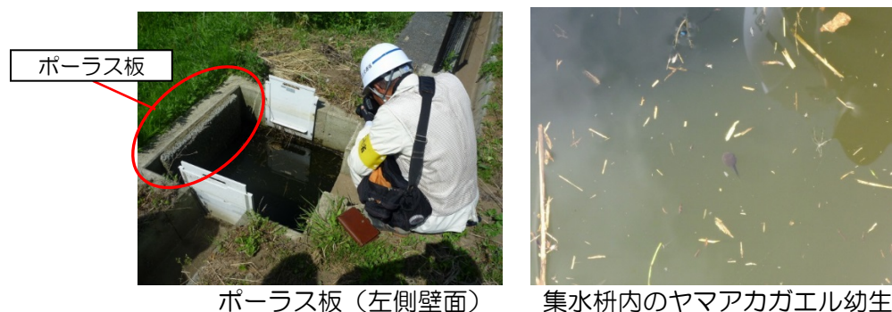
写真 6.2-2(5) 集水枡のポーラス板設置状況
