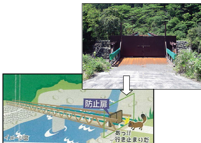
写真 6.2-2(6) 工事用道路橋梁部における侵入防止扉設置状況
