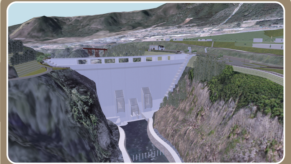
上流から見たダム
