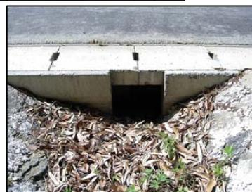
写真 6.2-2(4) U字側溝の脱出口設置状況
