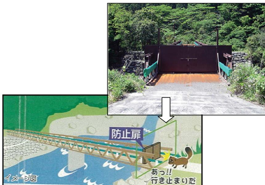
写真 6.2-2(6) 工所用道路橋梁部における侵入防止扉設置状況
